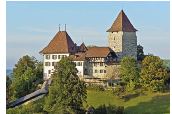
7 Adelsburgen des deutschsprachigen Raumes wiesen in der Blütezeit des 12./13. Jh. vielfältige Formen auf, jedoch war ein mittelgrosser Typus mit dem Bergfried an der Angriffsseite und dem Wohnbau auf der geschützten Spornspitze besonders verbreitet: Trachselwald BE, aus der Mitte des 13. Jh., bewahrt die Form trotz vieler Umbauten.
