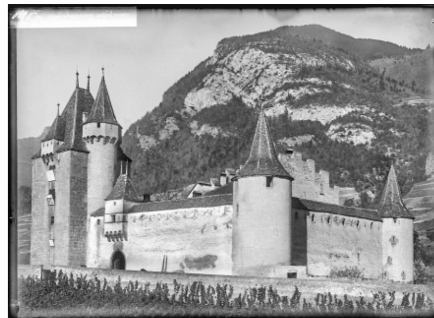
10 Aigle VD, Schloss. Resultat der bernischen Baumassnahmen zwischen 1497 und 1507 sind der aus der Flucht vortretende Turm, der Wehrerker über dem Portal, die heutige Form des Wohnbaus und der Ausbau der Ringmauer mit den Rundtürmen. Gesamtaufnahme um 1900.
