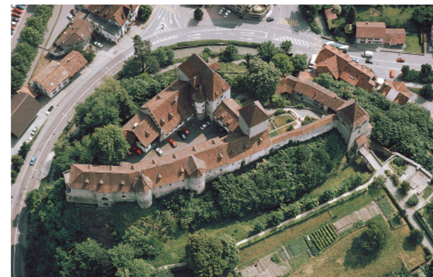
12 Burgdorf BE, Schloss. Blick nach Südosten.
